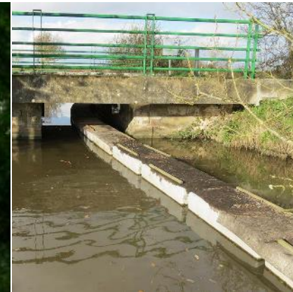
Passage à faune
